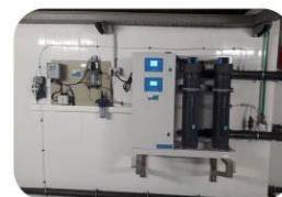
4. Clorador salino y centralita de control
