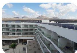
5. Paneles solar térmicos y fotovoltaicos
