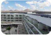
5. Solar- und Photovoltaikanlage
