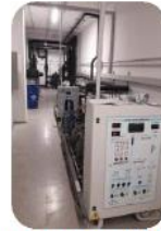
7. Positiv-Negativ-Kühlanlage mit geothermischer Energie
